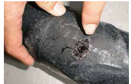
➤ Averías en cables con aislamiento de papel impregnado
