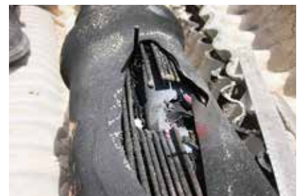
➤ Averías en empalmes
