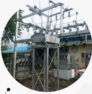
OPERACIÓN DE ALARMAS
