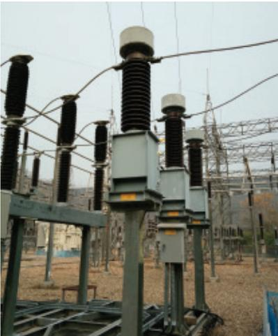
Evaluamos el estado de los transformadores de medida y protección, determinamos curvas de saturación, burden, polaridad y demás elementos para dar un diagnóstico del equipo y detectar posibles causas de falla que afecten la seguridad del esquema de protecciones.
